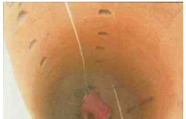
Le puits creusé
